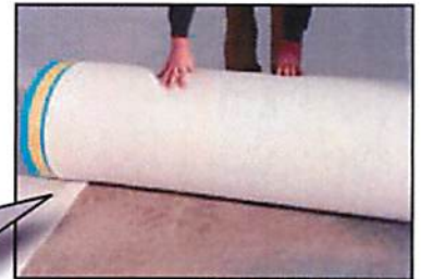
Een overlapping uitvoeren op de aangrenzende band
