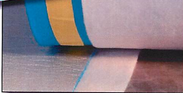
De overlapping in schuim die uitsteekt naast de viltlaag, hecht men vast aan het gealuminiseerde deel in schuim van de aangrenzende strook
