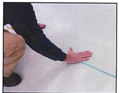
Een goede aandichting van de overlapping verzekeren
