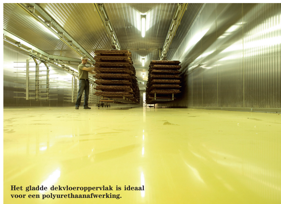
Een dekvloer met Vezel-Compound Duremit worden geplaatst zoals een klassieke dekvloer.
